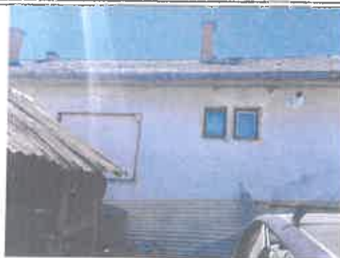
kert felőli homlokzat
